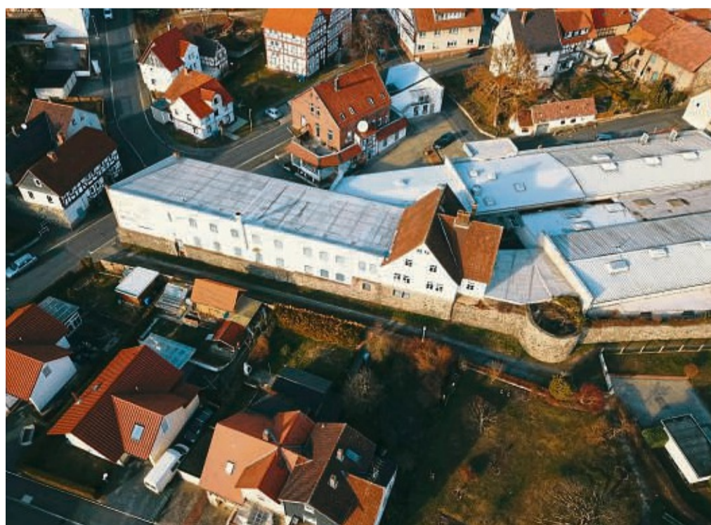
Steht direkt der Stadtmauer: Das alte Gebäude der ehemaligen Dickhaut-Fabrik samt angrenzendem Fachwerkhaus. FOTO: MARTIN THIERY
